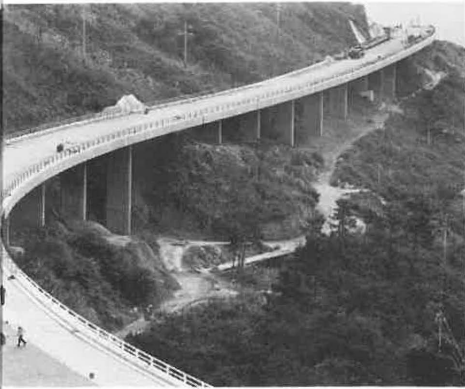
屯門公路有二公里路段是高架公路
