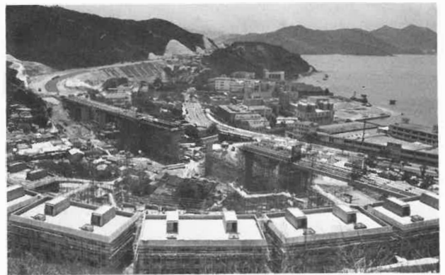
深井高架公路正在施工興建
